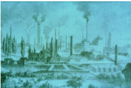
Fabrikanlage in Wuppertal
